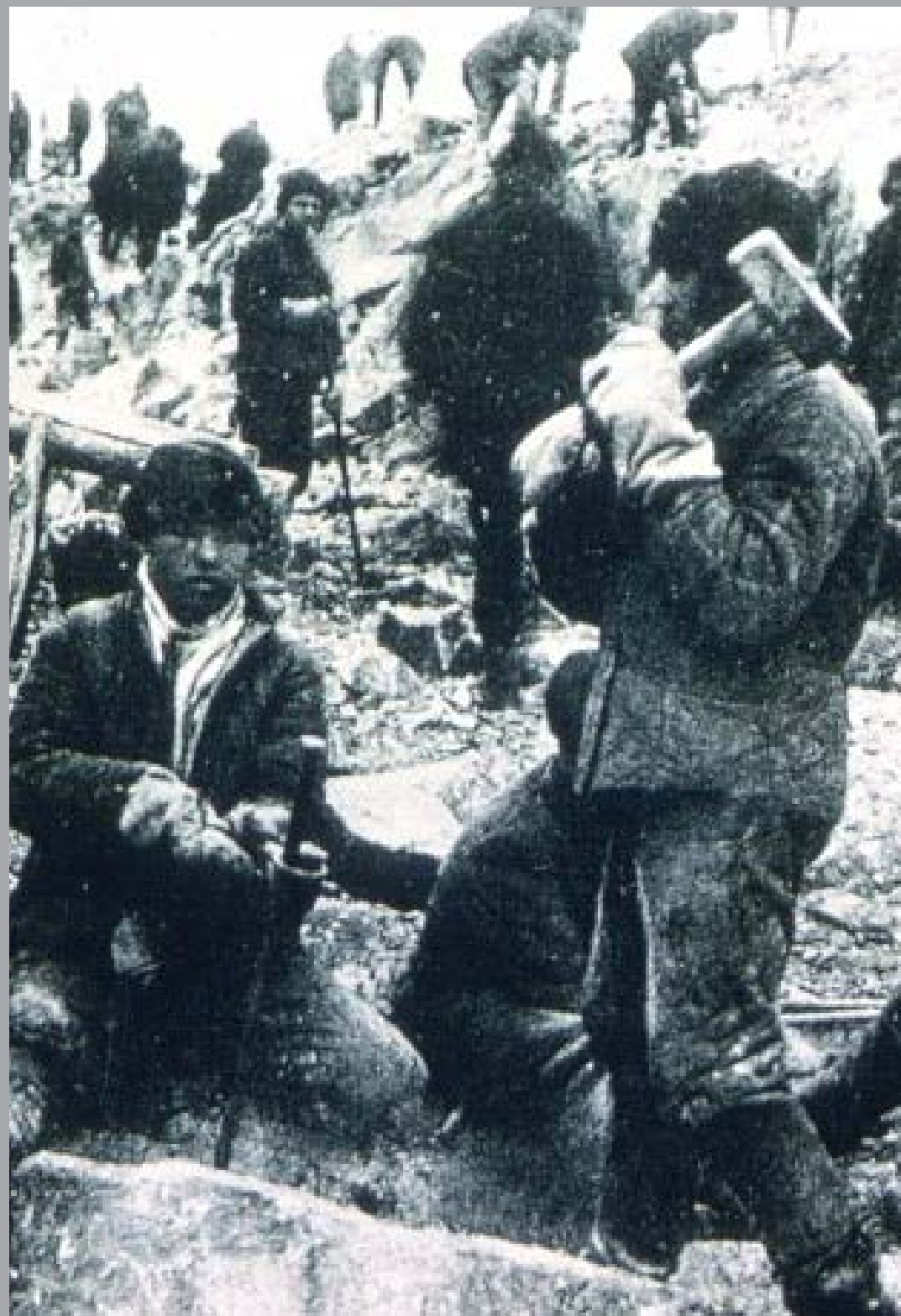
BUDOVÁNÍ BĚLOMOŘSKÉHO KANÁLU
